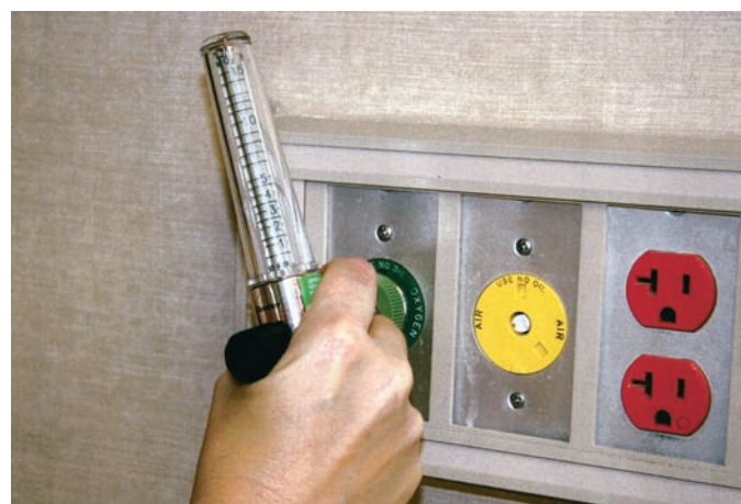
Figura 50-9 ■ Introducción del caudalímetro en la unidad de pared. (Shirlee Snyder)
